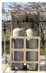
「EPS」は大規模災害からガス供給設備を守る容器スタンド。震度7相当の地震に対応した設計の他、直射日光を遮る庇も設置。
