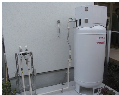
LPガスバルク貯槽（150kg）
