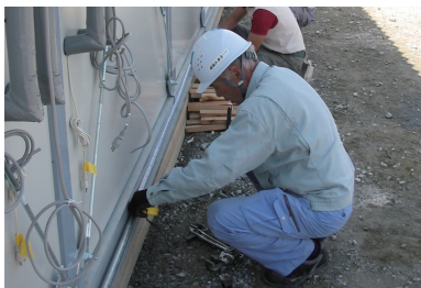
仮設住宅(南相馬市)での供給設備設置工事
