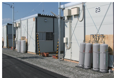
仮設住宅に設置されたLPガス
