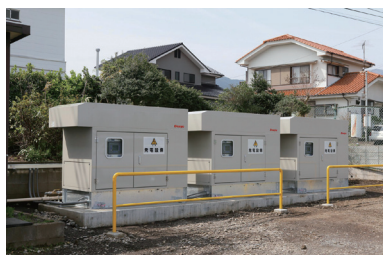
非常用発電機
