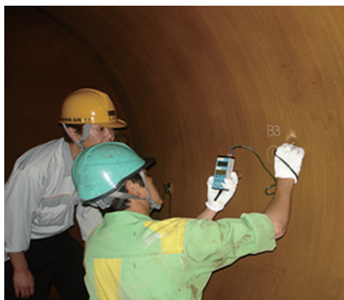
貯槽開放肉厚測定検査 貯槽の内部から板厚の測定を行い、安全かどうか確認します。
