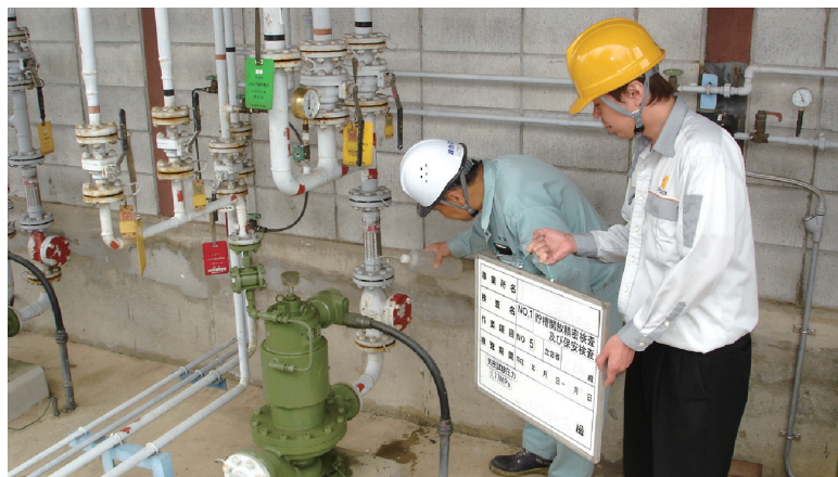
配管気密試験 配管からの漏れがないかどうか検査をします。
