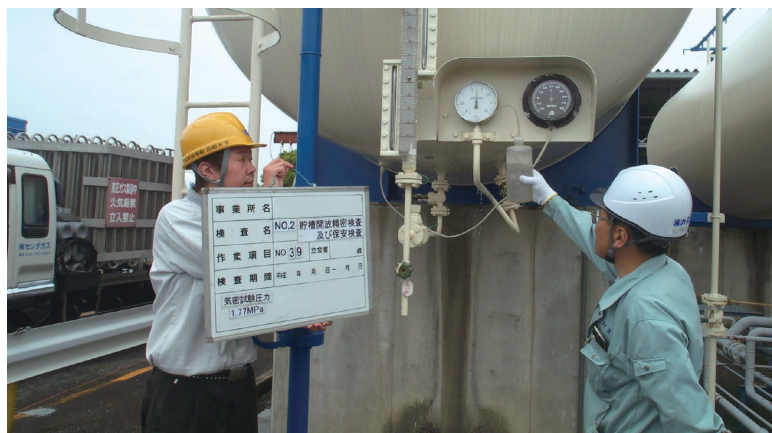
貯槽気密試験 貯槽からの漏れがないかどうか検査をします。
