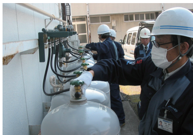
避難所(埼玉県加須市)に供給設備を設置
