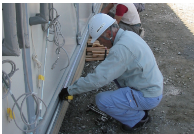
仮設住宅(南相馬市)での供給設備設置工事
