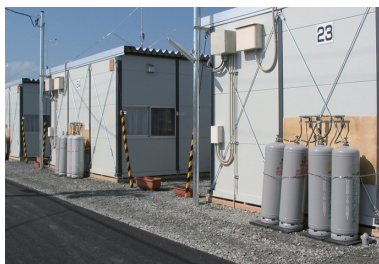
仮設住宅に設置されたLPガス
