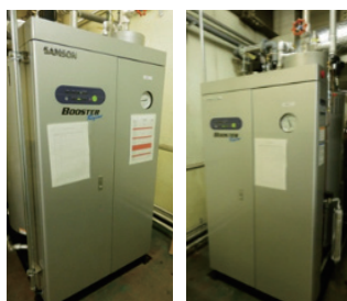
サムソン製ボイラーBOα-750N
