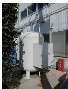
LPガス1t貯槽
