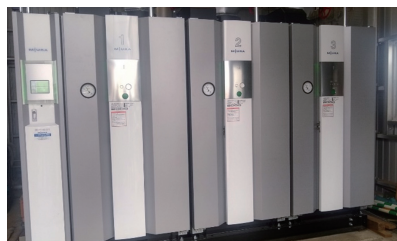
三浦工業製2tボイラー3台
