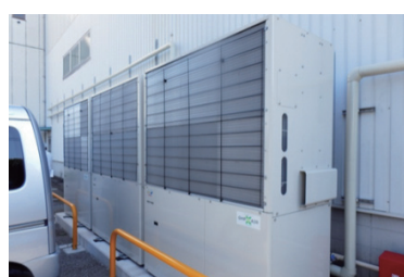
ヤンマー製GHP室外機
