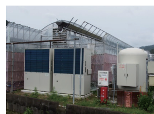
ヤンマー製エグゼアYNZP560J-PB・LPガス貯蔵バルク985kg
