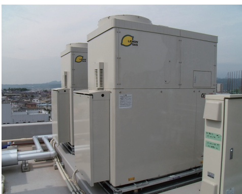
コージェネレーションシステム
