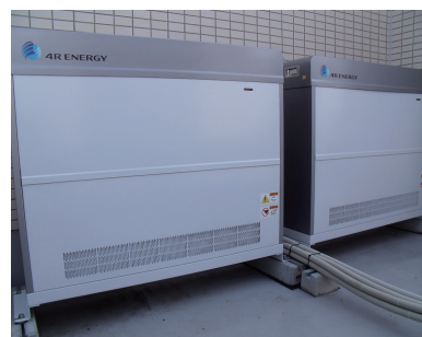
リチウムイオン蓄電池
