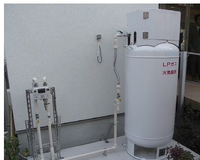
LPガスバルク貯槽（150kg）
