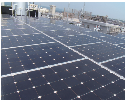
太陽光パネル
