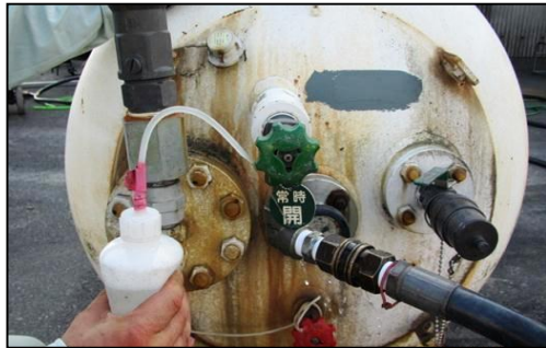
接続部のガス漏れ確認
