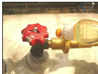
接続部のガス漏れ確認
