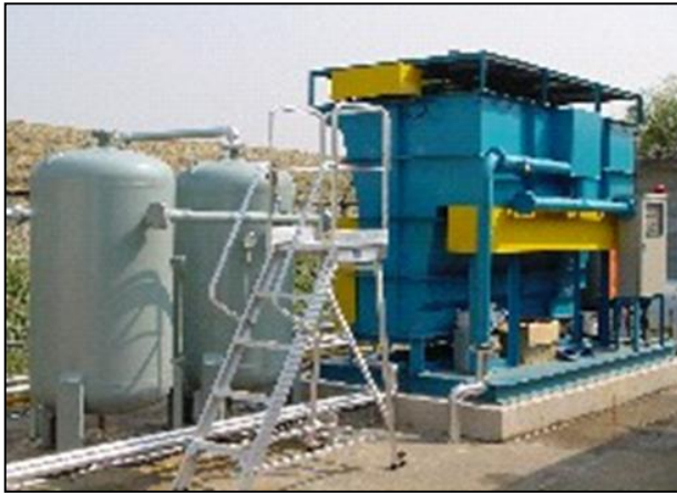
処理水ろ過装置
