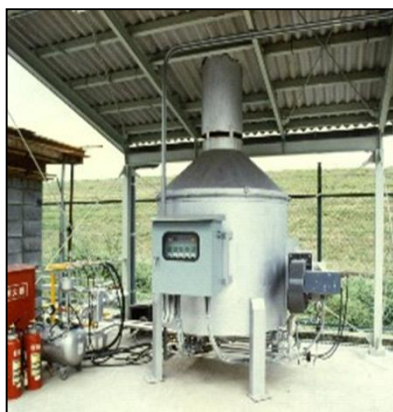
残ガス燃焼装置
