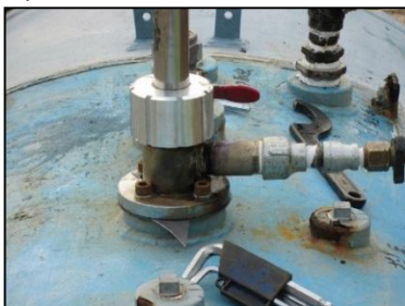
水置換状況 (例)
