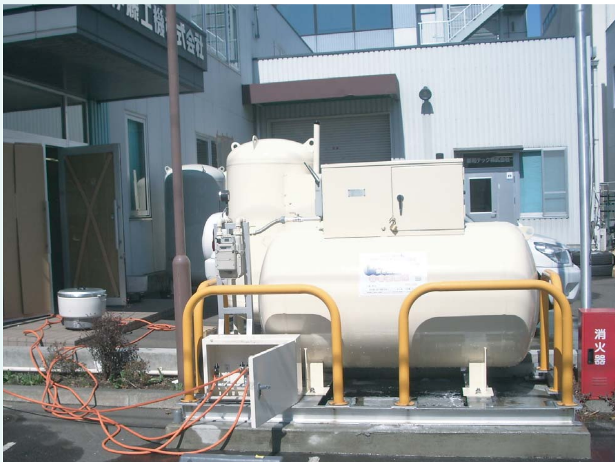
写真: 災害時対応バルクシステム
