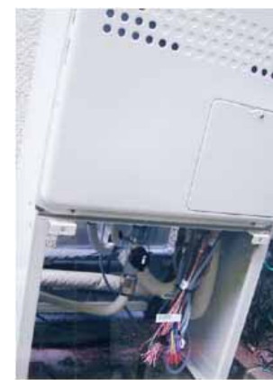
×ドレン配管中心
